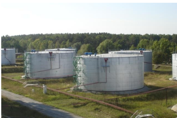
Рис. 1 - Пример ограждения резервуарного парка земляным обвалованием
