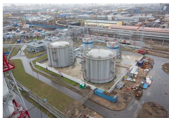
Рис. 2 - Пример ограждения резервуарного парка железобетонной стеной
