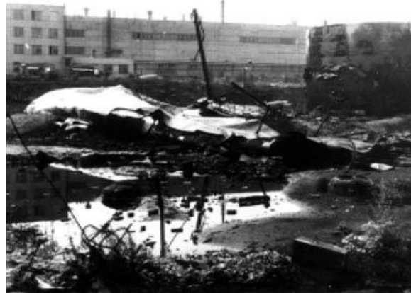
Рис. 5 - Разрушенный резервуар. Произошло разрушение сварного соединения
